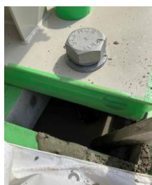
基礎アンカー補修
