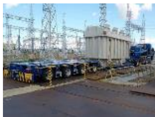
トレーラから積み下ろし
