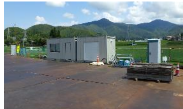
塔内仮設設置
