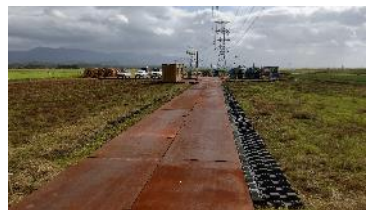
車両運搬路設置
