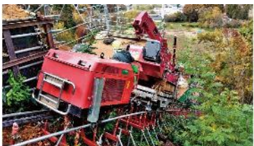
モノレール運搬路設置
