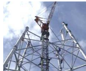
クレーン組立作業
