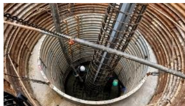
コンクリート打設作業
