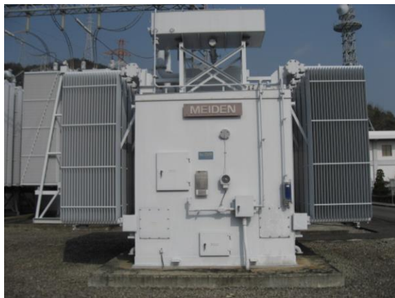
分路リアクトル (ShR : Shunt Reactor)
