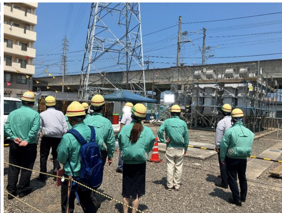
電力用コンデンサ撤去 現地視察状況
