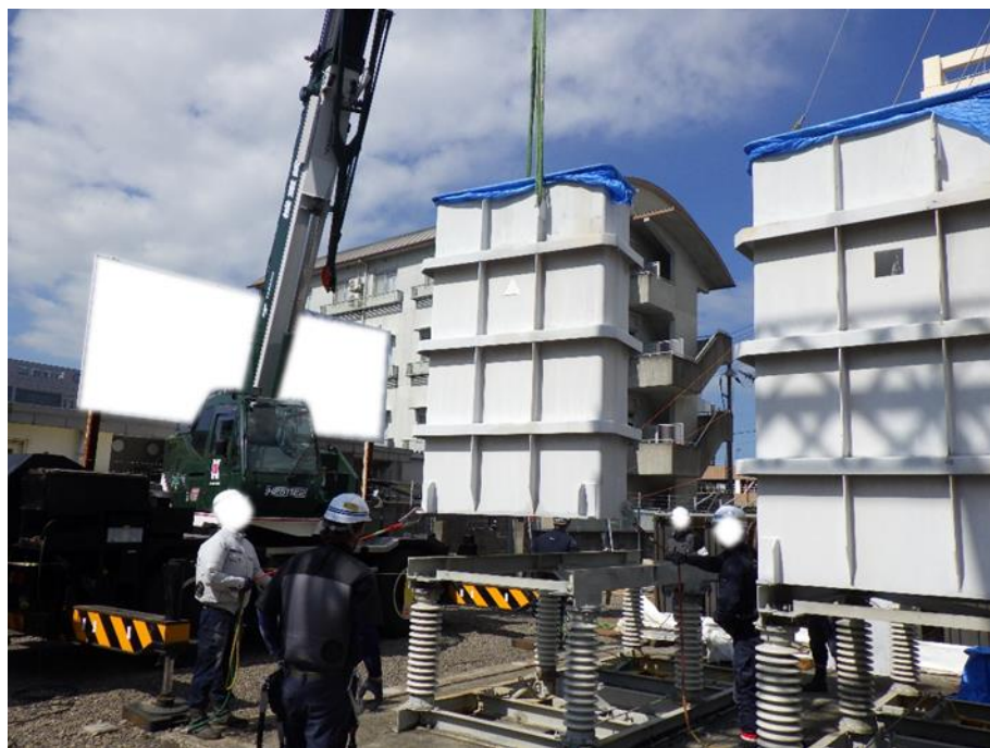
電力用コンデンサ撤去 工事状況
