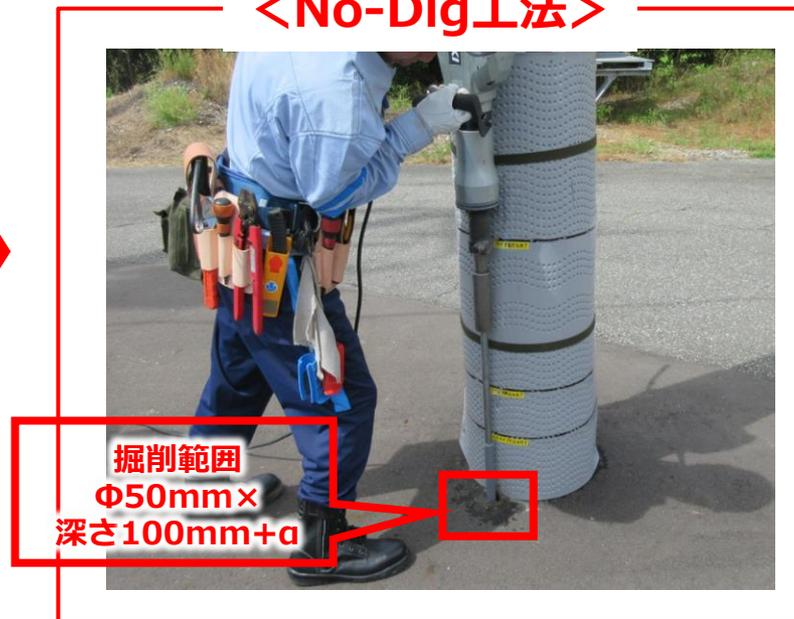
電柱地際を局所的にドリル等で掘削し、地上より接地極を打込み
