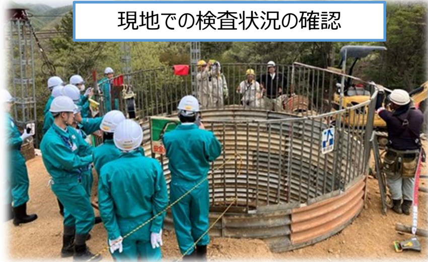
現地視察状況②: 傾斜地における鉄塔基礎工事
