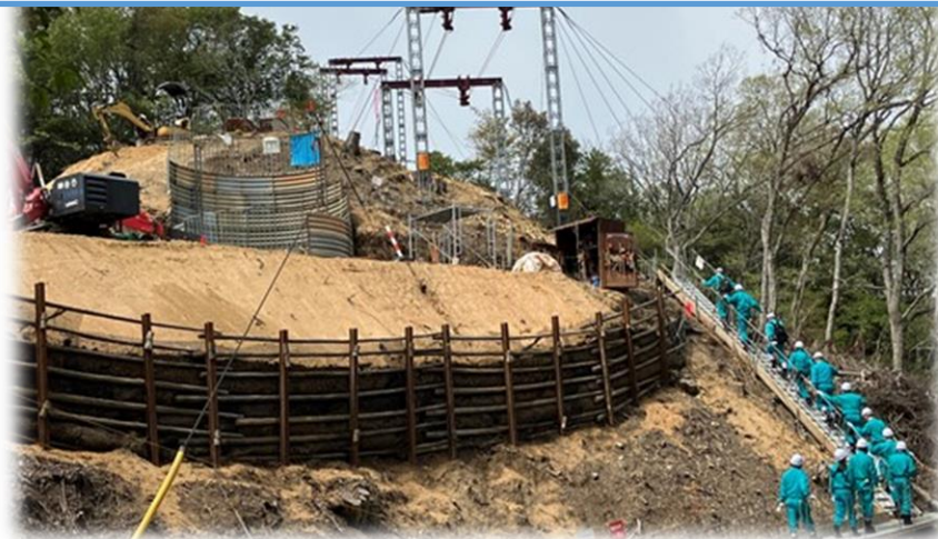
現地視察状況①: 傾斜地における鉄塔基礎工事
