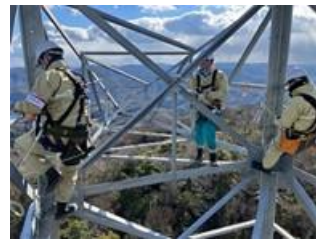
《部材取付・ボルト締め》
