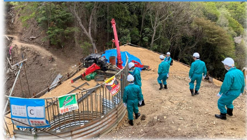
現地視察状況②: 傾斜地における鉄塔基礎工事
