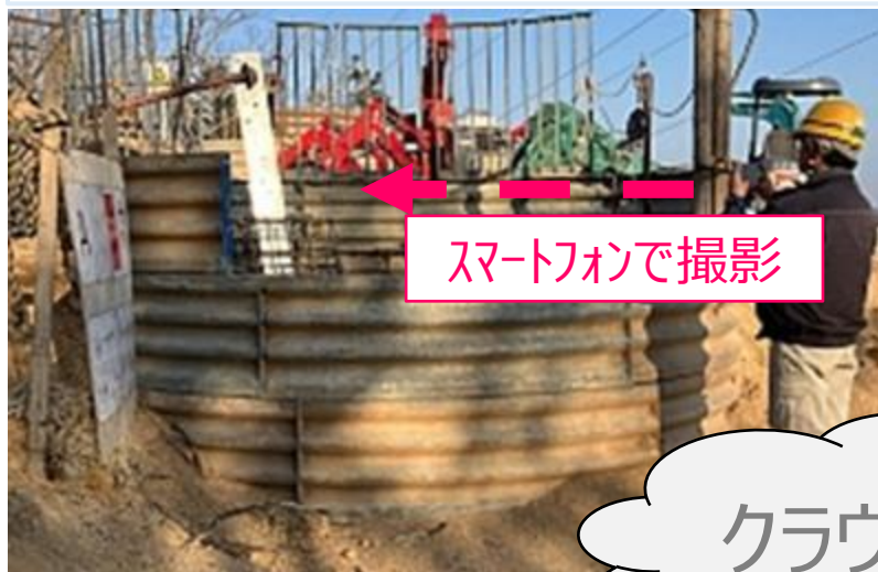
《工事現場》 工事会社
