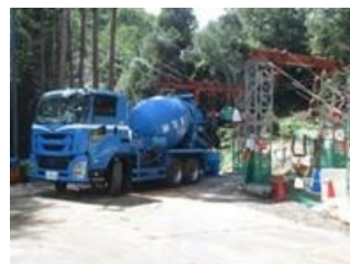
《コンクリート打設》
