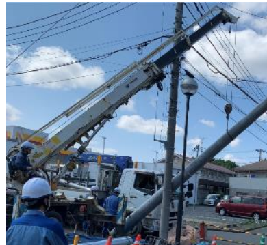
コン柱新設工事
