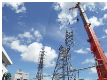
重機等による鉄塔組立
