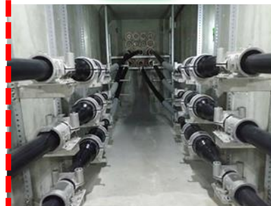
写真：人孔内部（接続部）
