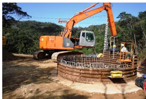
掘削・配筋・ コンクリート打設・埋戻し等
