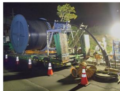
ドラム場・エンジン場設置 ケーブル布設・接続工事等
