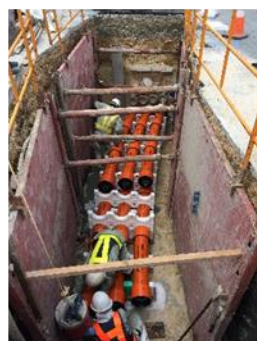
掘削・管路布設 埋戻し等
