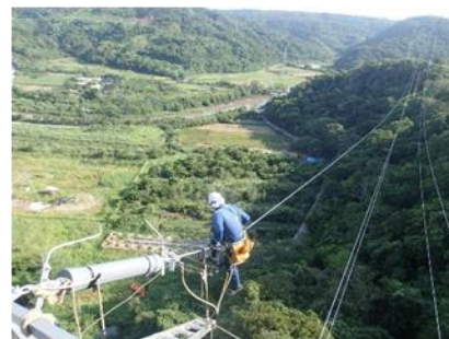
ドラム場・エンジン場設置 延線・緊線工事等
