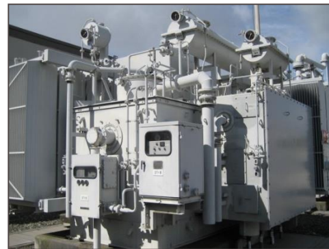
77kV/6.6kV変圧器
