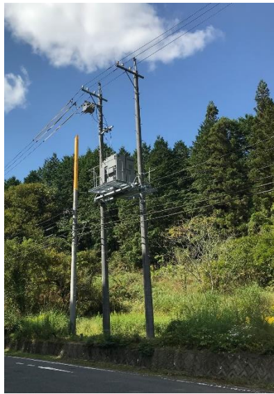
図 2 - 6 無効電力補償装置の例
