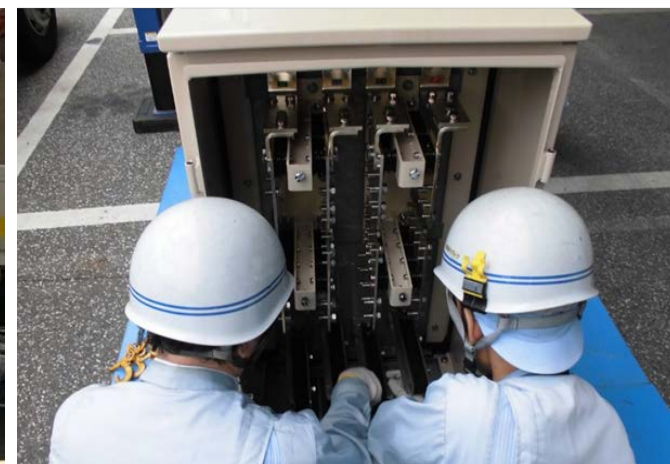
変圧器塔扉外し （同時並行作業）
