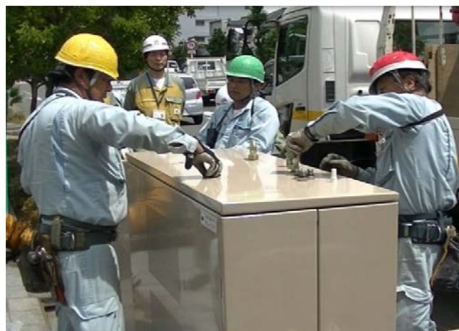
アイボルト外し、化粧ボルト外し （事前作業）
