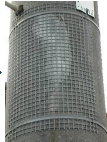
補修後 (剥落防止ネット取付後)
