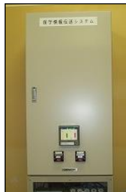
保守情報伝送装置（左）と屋外カメラ（右〔変電所鉄構取付状態〕）
