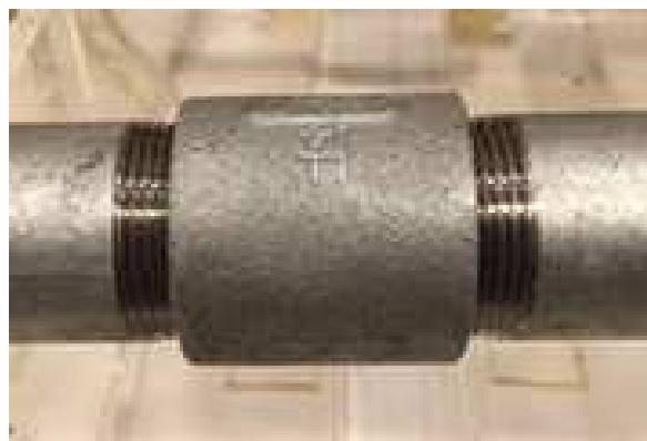
ねじ接合管(白ガス管)の接合部
