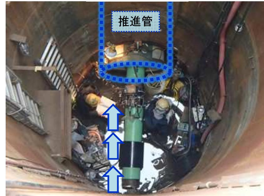
立坑下での作業状況(ガス導管の配管)
