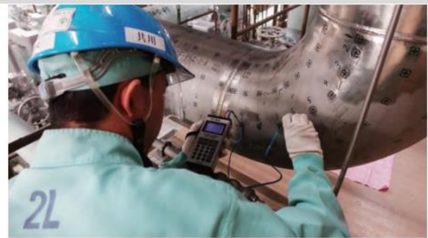
【写真】配管減肉に係る検査の様子
