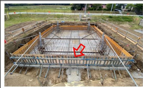
《効率化前》（木製型枠）
