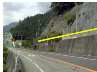
山地の道路沿いの擁壁上部
