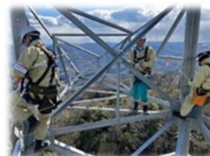
《部材取付・ボルト締め》
