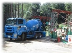
《コンクリート打設》
