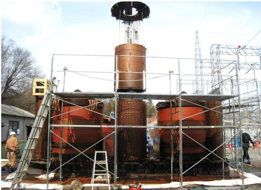
【変圧器コイルの劣化調査の様子】
