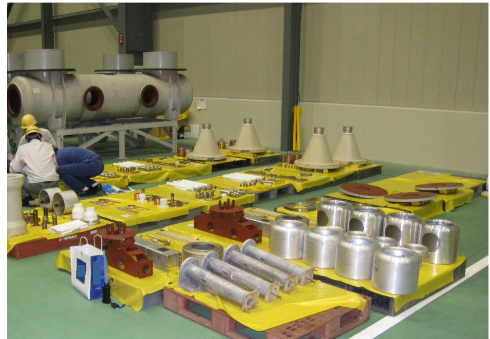
【遮断器の劣化調査の様子】
