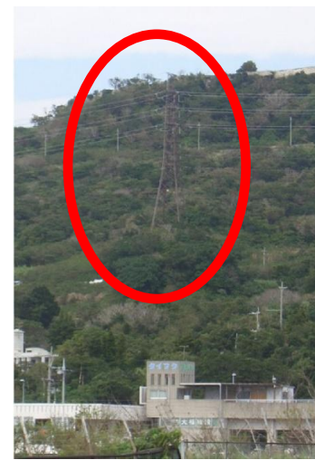
環境調和塗装の鉄塔 (現地塗装)
