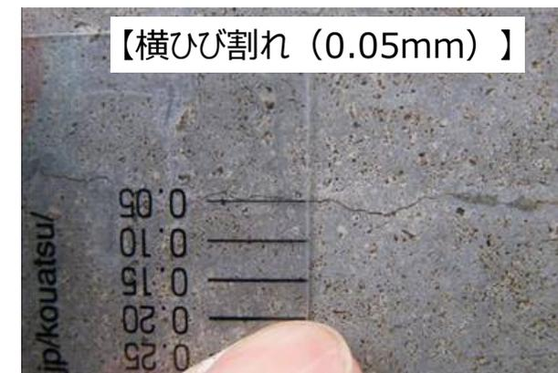
0.05mmのひび割れは、目視で確認できるレベルであり、一般的には髪の毛程度とされています。
