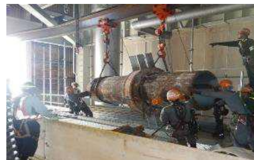
＜ボイラー設備の経年化対策工事状況＞
