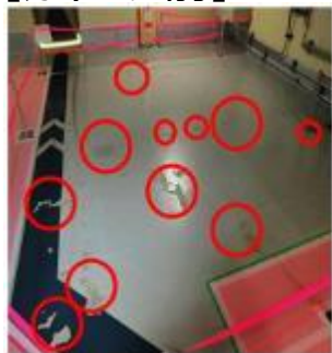
劣化が点在するエリア全体を修繕
