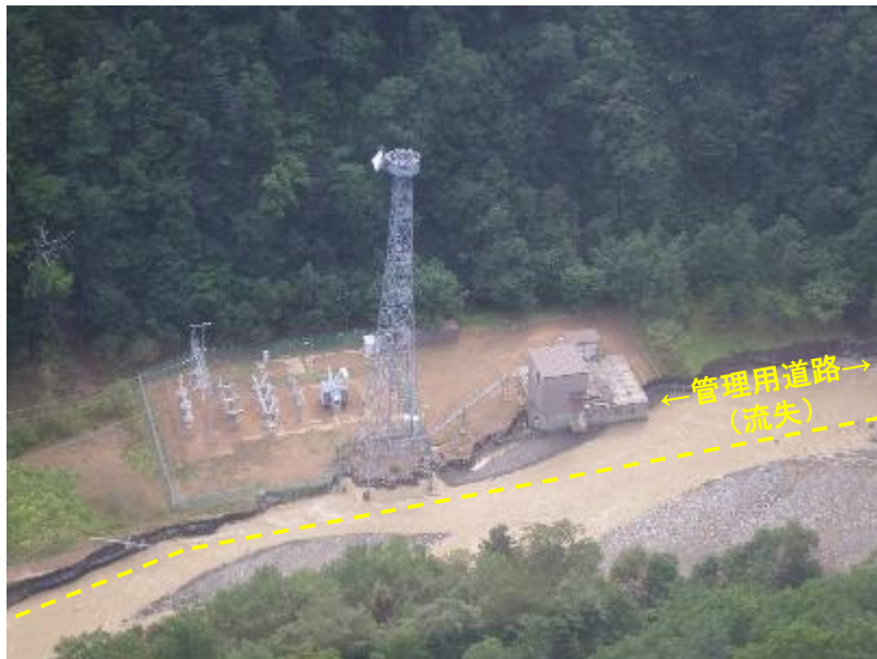
2016年台風被害（奥沙流発電所）
