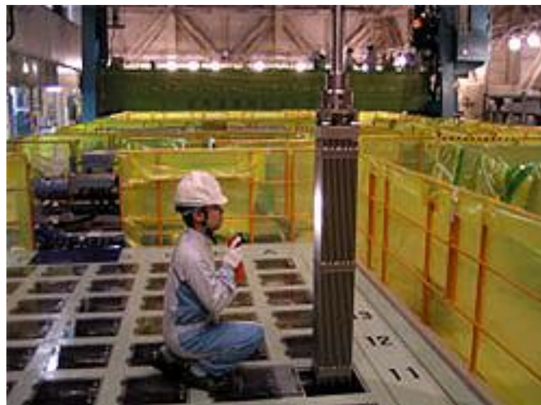
<燃料ピット点検状況(燃料棒の目視検査)>
