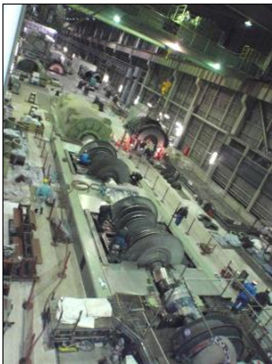
＜蒸気タービンの分解点検状況＞
