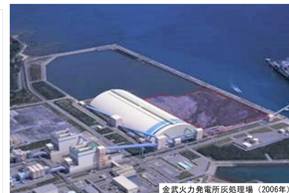
金武火力発電所灰処理場（2006年）
