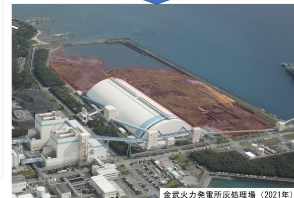
金武火力発電所灰処理場（2021年）
