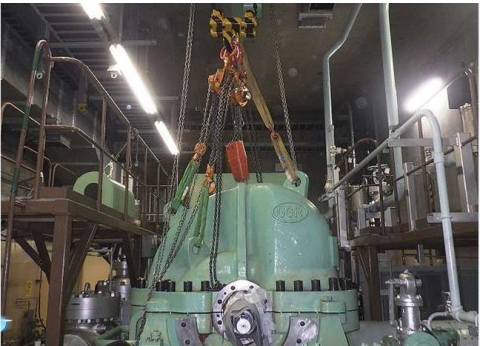
高圧復水ポンプの分解点検
