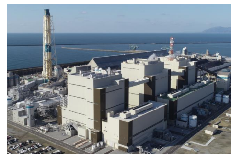
能代火力発電所全景（手前が3号機）
