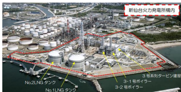
新仙台火力発電所3号系列
