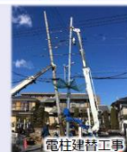
電柱建替工事
