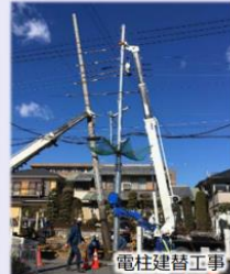
電柱建替工事
