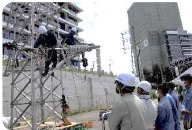
がいし装置取り外し作業見学
