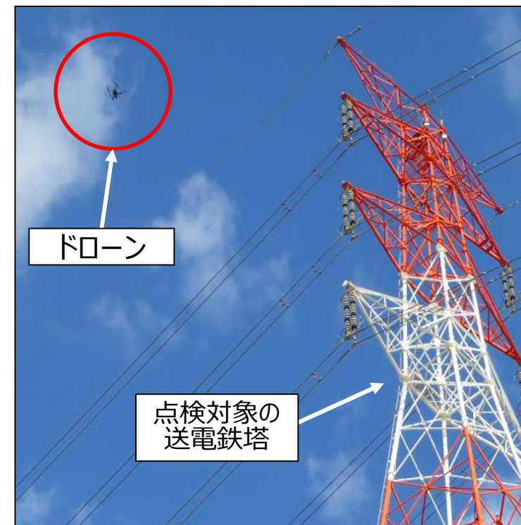
（実際の点検状況）
