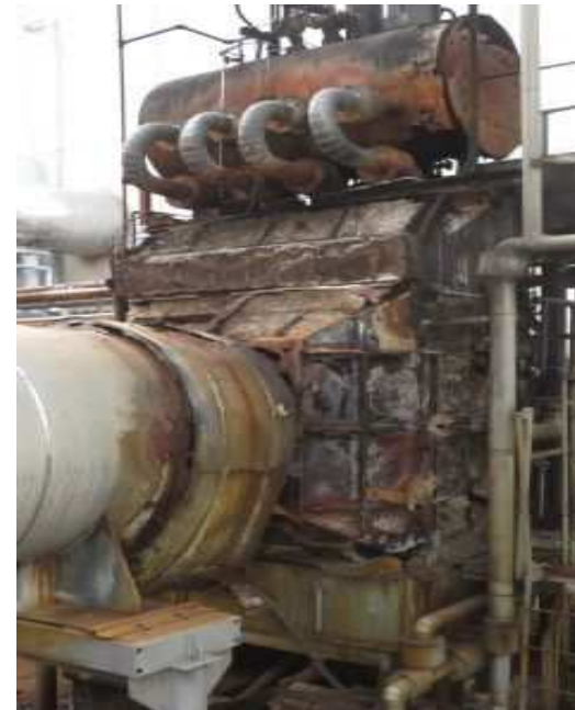
高経年化状況（排ガス熱回収装置）
