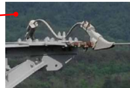
[がいし・ジャンパ装置の点検]
