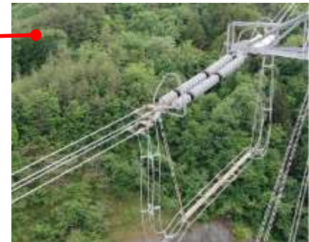
[がいし・ジャンパ装置の点検]
