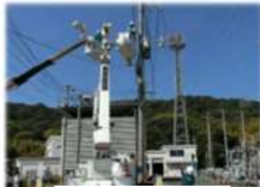
・引込線張り上げ
