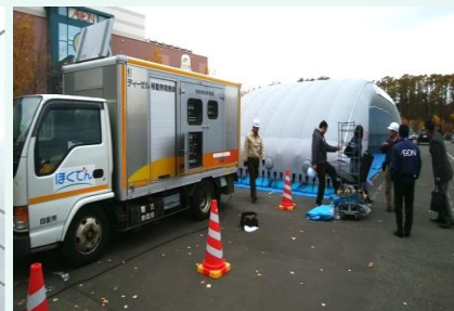
移動発電機車による電力供給
