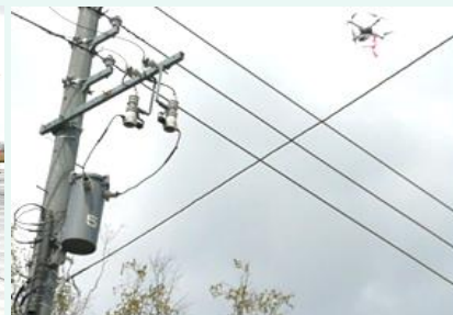
ドローンによる設備確認
