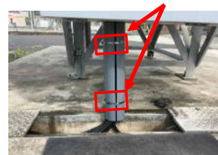
②'半割塩ビ管、 ②'ステンレスバンド取付
