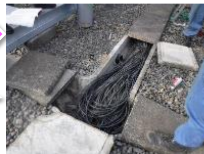
②'ケーブル流し配線後、 ④'末端処理・養生実施
