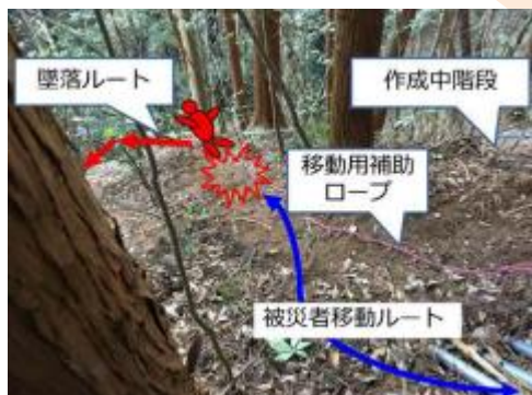
巡視路整備業務にて斜面からの墜落災害が発生
