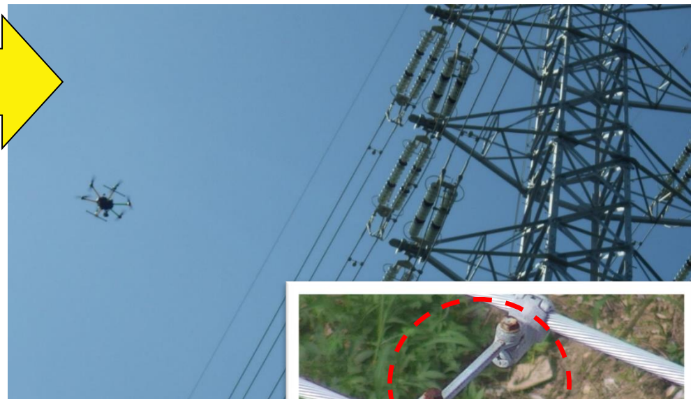
ドローンを活用した 点検状況
