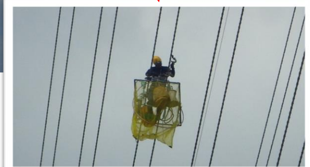
従来の点検状況
