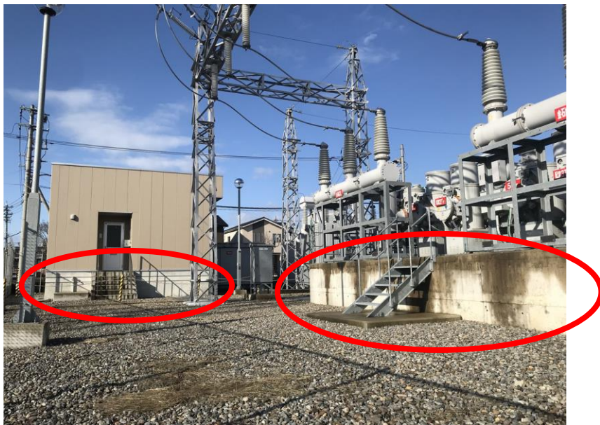
建物および開閉装置の嵩上げ
