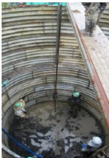
63.5kgの錘を高さ76cmから落下させ、30cm貫入に要する回数を求める試験
